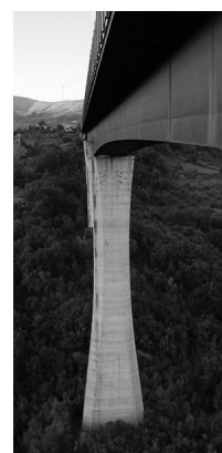
Piloni a uniforme resistenza di un viadotto autostradale.
