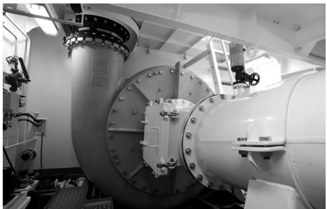
Figura 7 Pompa centrifuga per il trattamento delle acque di rifiuto.
